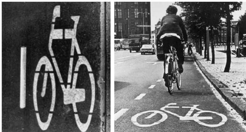
圖 14 自行車道圖示在不同角度的視覺感受，實際繪製觀點（左）騎士觀點（右）
